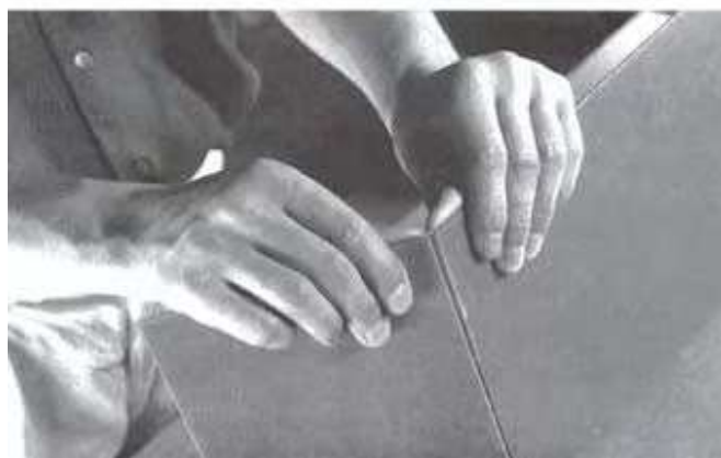
Рисунок 11 - Нанесение бороздки и поломка
